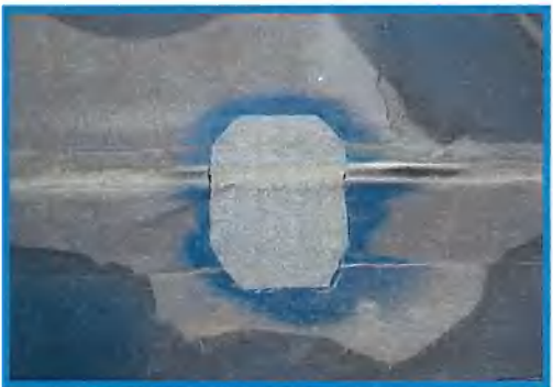
Diverse reparaties uitgevoerd
