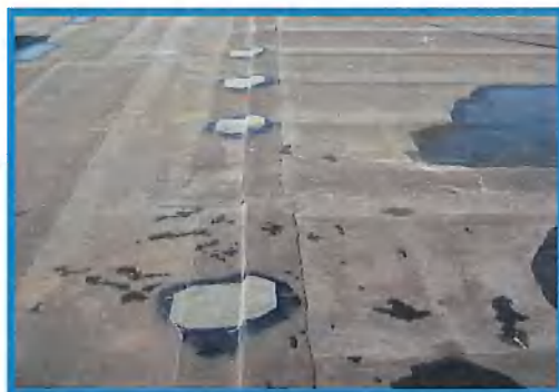
Diverse reparaties uitgevoerd
