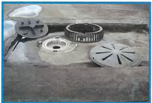
Alle pluvia's ontkoppeld en gereinigd
