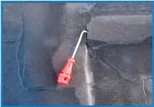
Diverse gebreken tpv naden en overlappen
