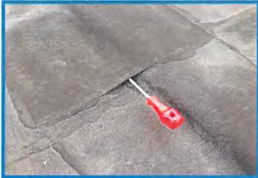
Diverse gebreken tpv naden en overlappen
