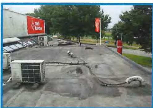
Tegeldragers onder kabels geplaatst
