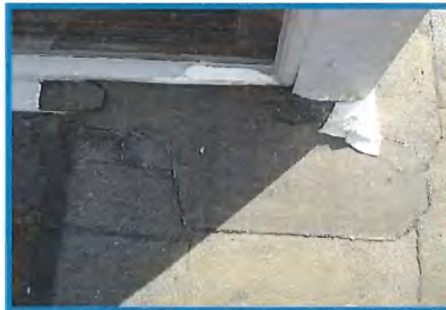
Diverse reparaties uitgevoerd
