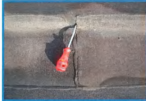
Diverse gebreken tpv naden en overlappen
